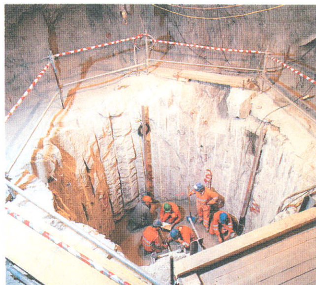
Земляные работы для крупномасштабного испытания, проведенные японской компанией в подземной лаборатории Nagra в Швейцарии The excavation for a large scale test performed by a Japanese organization at the Nagra underground lab in Switzerland
